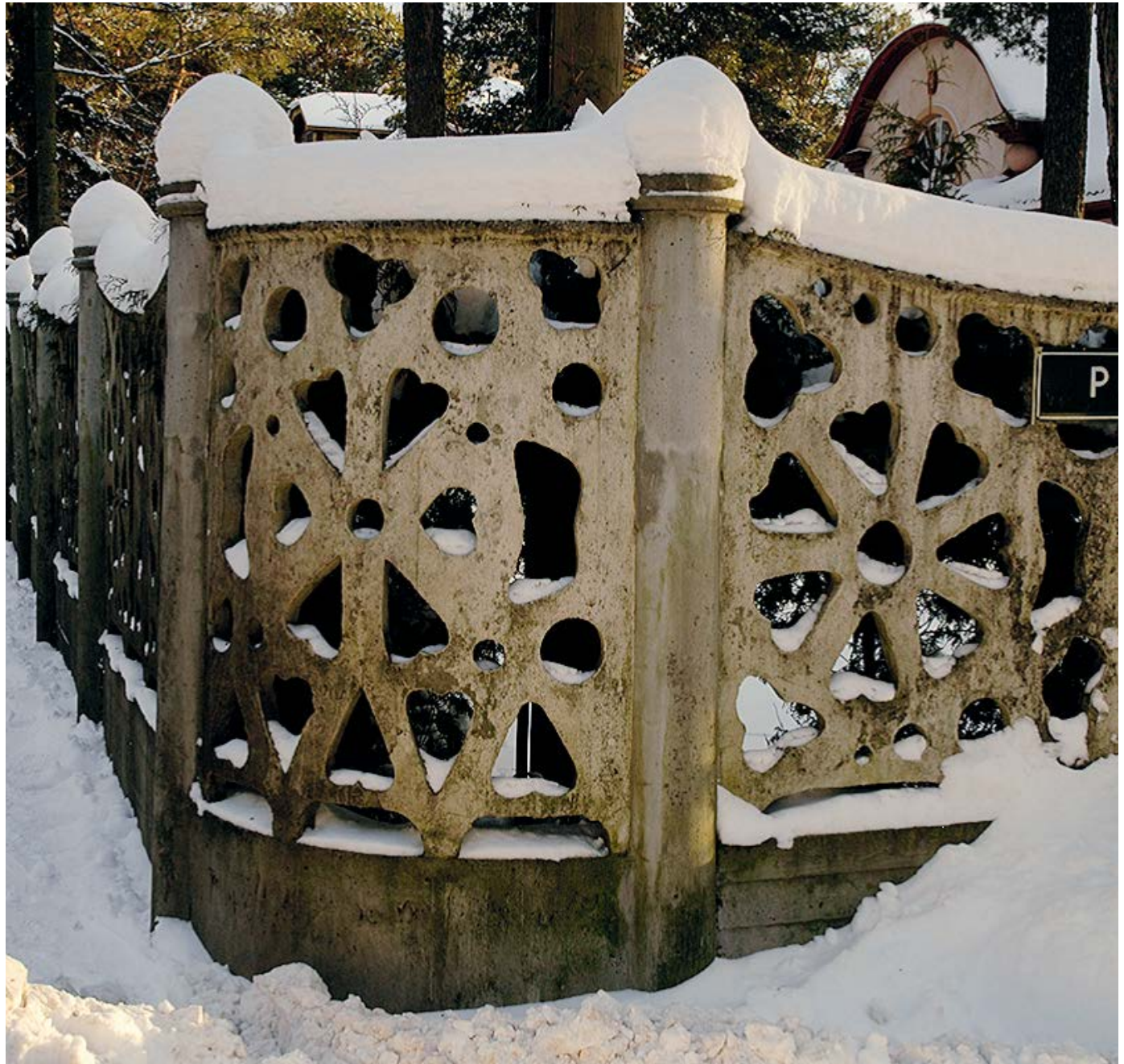
Talvine kliima ja libeduse tõrjeks kasutatav sool võivad betoonpindadele kahjulikult mõjuda. Erilise kujundusega raudbetoonaed (1935) Nõmmel Pesa ja Õie tänava nurgal on kultuurimälestis. Foto: M. Mändel
