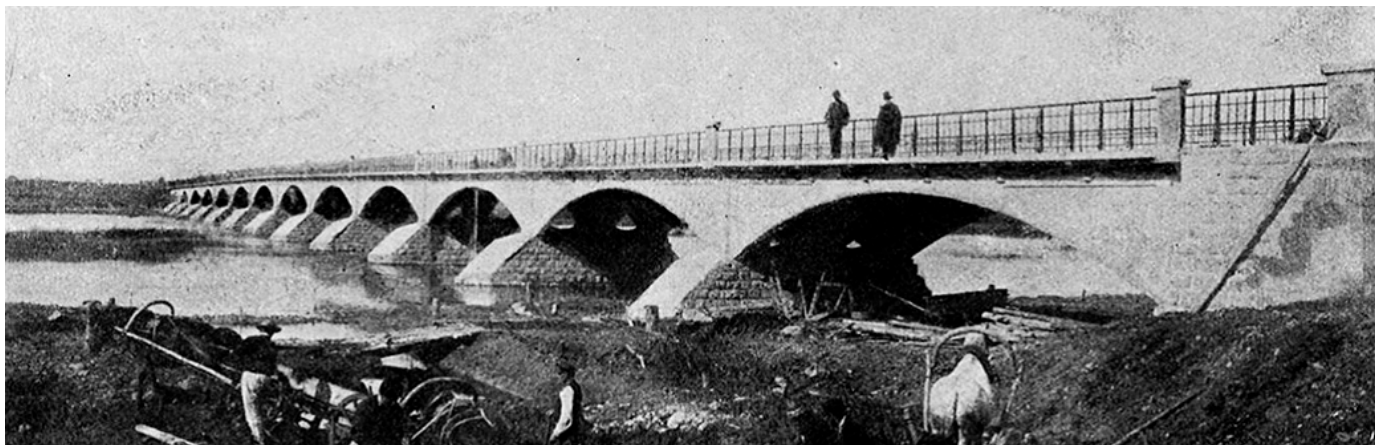
Eesti esimene raudbetoonsild (1904) üle Kasari jõe oli valmimisjärgselt Euroopa pikim raudbetoonsild. Foto: Le Béton Armé, november 1904
