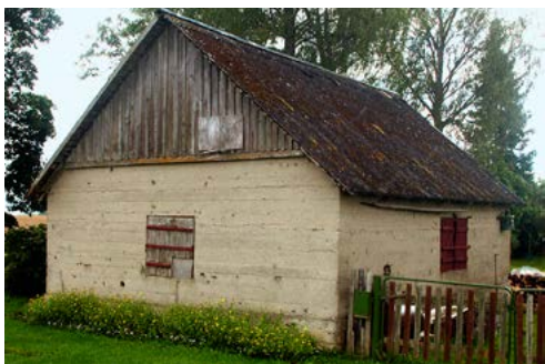
Vabariigi ajal tehti abihooned vahel betoonseintega. Sellised tagasihoidlikud hooned on kohaliku betooniajaloo kontekstis olulised ja vääriksid säilitamist. Foto: M. Mändel
