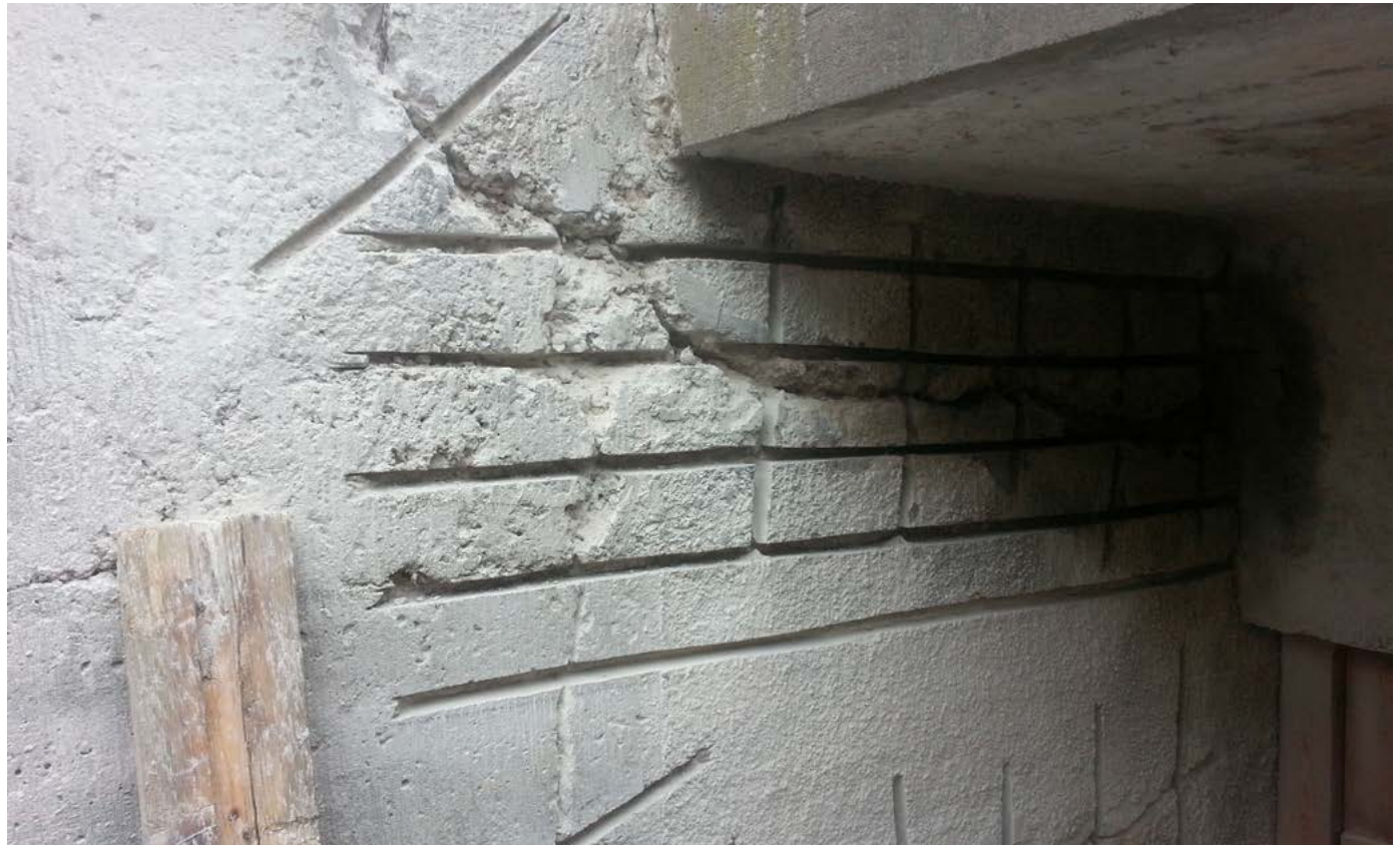
Betooni pealispinda on lõigatud sooned konstruktsiooni tugevdamiseks ettenähtud lisasarruste paigaldamiseks. Foto: M. Mändel
