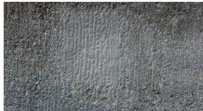
Eeskujulik betooniparandus: toon ja faktuur on õiged, paranduskoht korrektse ristkülikuna vormistatud. Foto: M. Mändel
