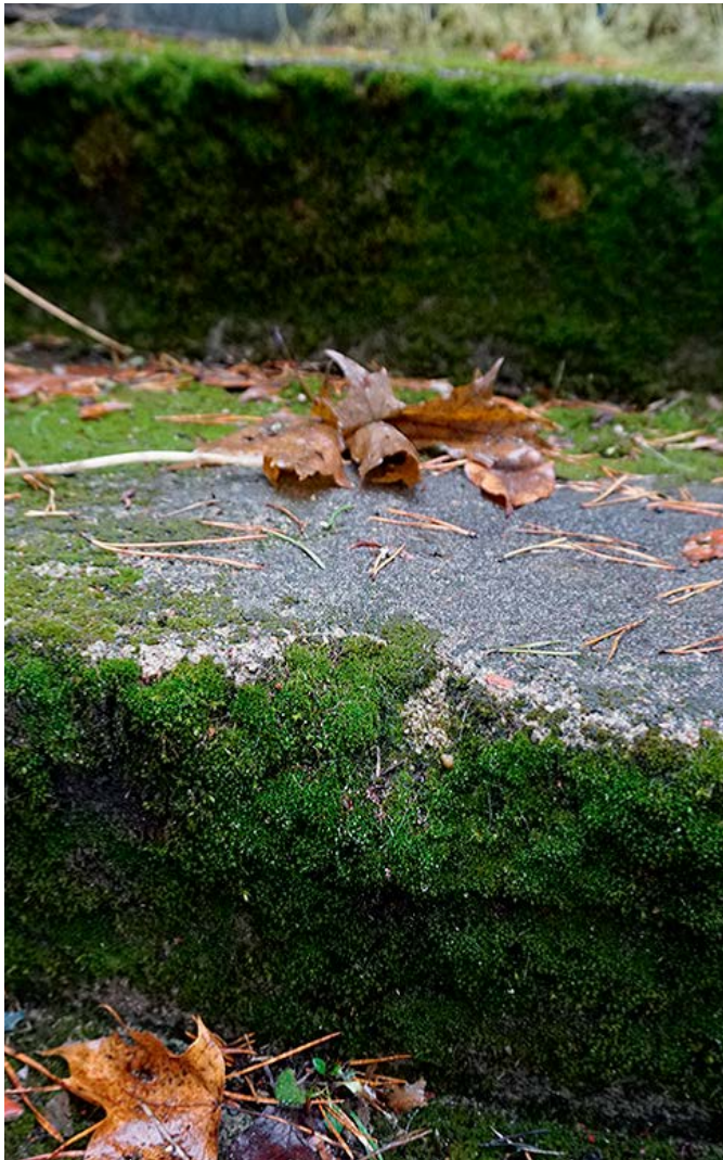
Sammal betoonil põhjustab pinna aeglast murenemist. Foto: M. Mändel
