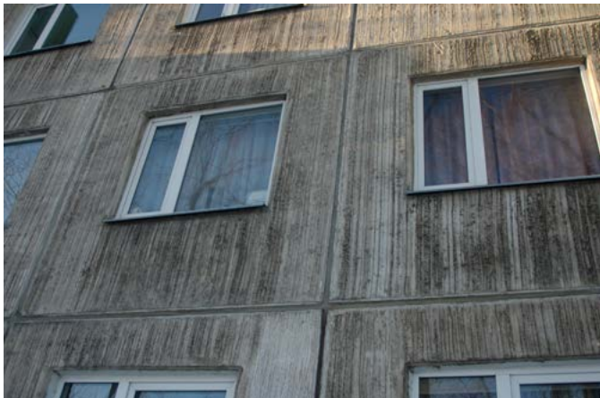
Nõukogude perioodil ehitati massiliselt monteeritavatest raudbetoonpaneelidest korterelamuid. Foto: M. Mändel
