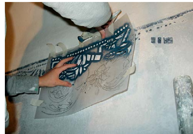
Trafareti kinnitamine seinale. Torma kabeli trafarettmaalingu taastamine. Foto: K. Toom
