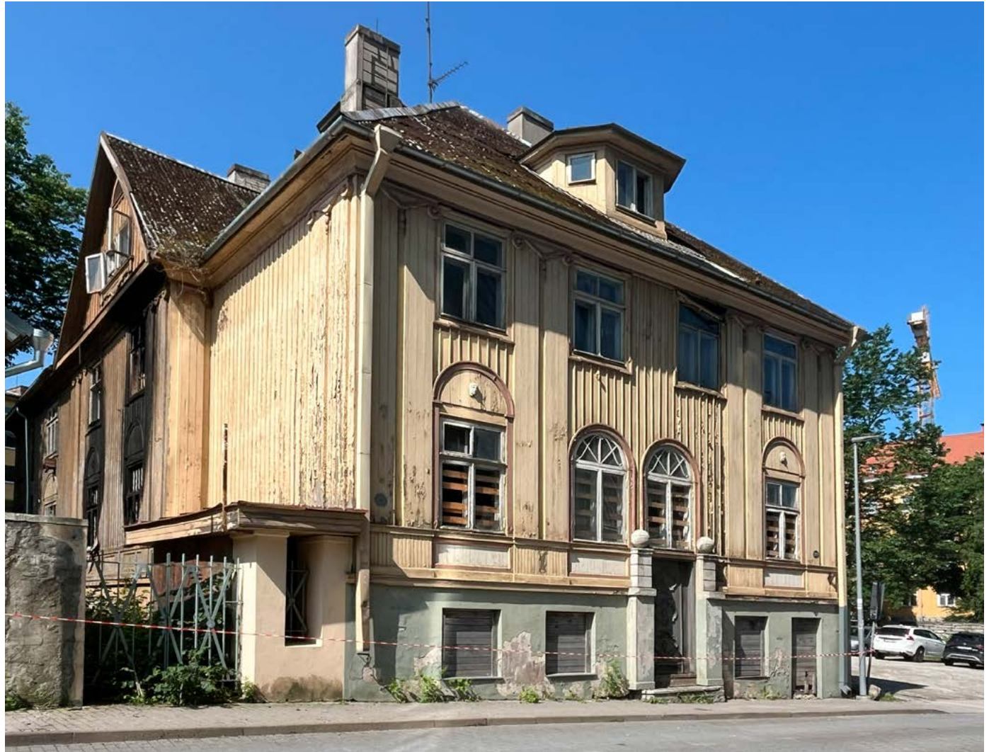
Tules kannatada saanud ehitismälestisest Lennuki tn 26 hoone. Ehitise alumise korruse avad on korrektselt suletud. Foto: A. Anton
