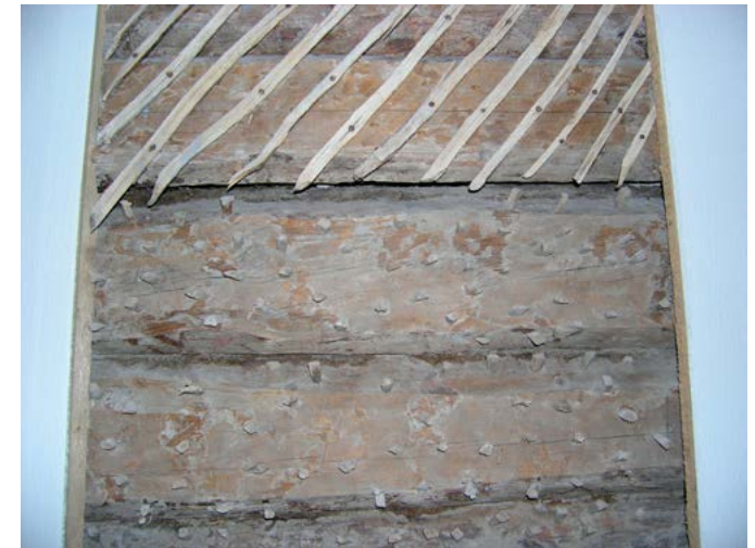
Varem krohviti lubimördiga otse palkseintele, mis olid paremaks nakkumiseks puupulki täis löödud. Krohvi hoidmiseks on seinale kinnitatud ka diagonaalselt ja risti naelutatud krohvipeerge ja rooplaate. Foto: K. Tooming
