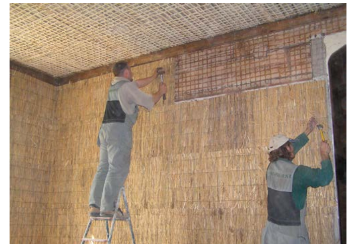
Pilliroost krohvimati ehk rooplaadi paigaldamine. Foto: Säästva Renoveerimise Infokeskus
