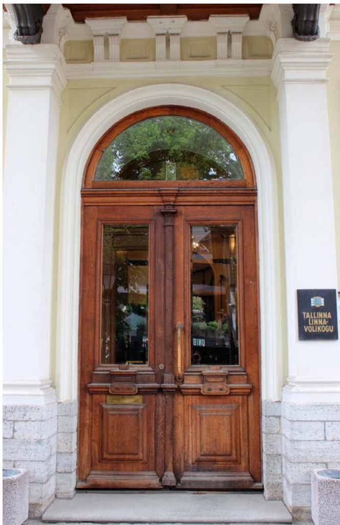
Vana-Viru 12 hoone aaderdatud välisuks, Tallinn. Foto: C. Valge
