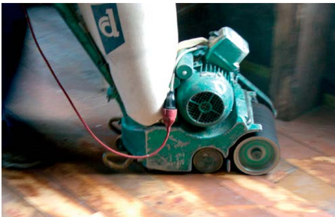
Põrandalt värvi või konaruste eemaldamiseks kasutatakse lihvmasinaid. Pildil trummellihvija. Foto: Säästvad Ehituslahendused
