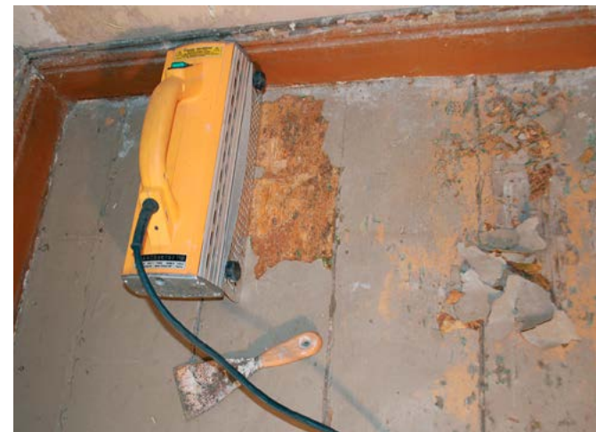
Infrapunakiirguse toimel töötav värvi põrandalt värvieemaldaja pakub kuumaõhupüstolile alternatiivi. Foto: R. Soodla
