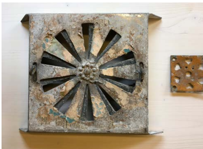
Ajaloolistel parkettpõrandatel leidub kaunilt kujundatud ventilatsiooniavasid. Neid tasub restaureerida ja taaskasutada. Fotod: Säästvad Ehituslahendused
